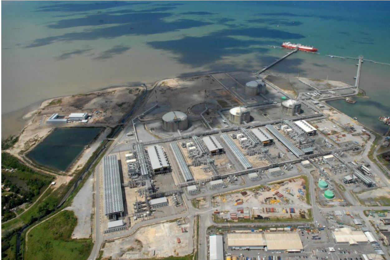
Atlantic LNG facility in Pt Fortin.
